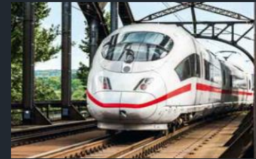
Oder im Bahnoberbau Permanent way
